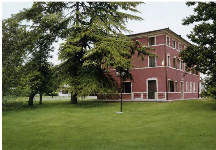
Dopo il 1986, apertura della casa alloggio da 55 posti
